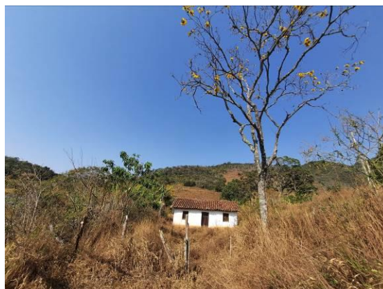
Foto: Ademir Nogueira de Ávila. Data: 27/08/2021 Areião de Cima – edificação existente no perímetro de entorno do tombamento.
