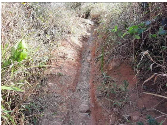
Foto: Ademir Nogueira de Ávila. Data: 27/08/2021 Areião de Cima - Trechos de erosão na trilha
