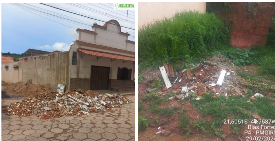
Figura 46 – Descarte irregular de RCC em logradouro público e lote baldio Fonte: Seletiva, 2024.
